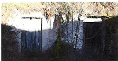
Felsenkeller am südöstlichen Ortsrand von Nennslingen. Aufnahme: 14.01.2020, vom Westen her aufgenommen. Urheber/Fotograf: linkw Copyright/Lizenz: Laut Vereinbarung
